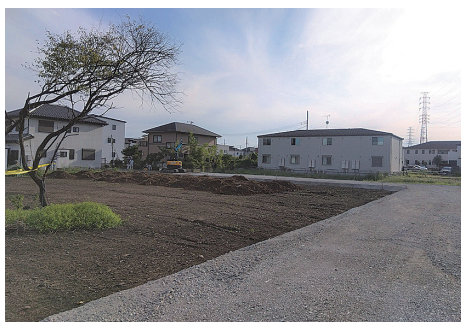
宅地造成工事の現場見学
